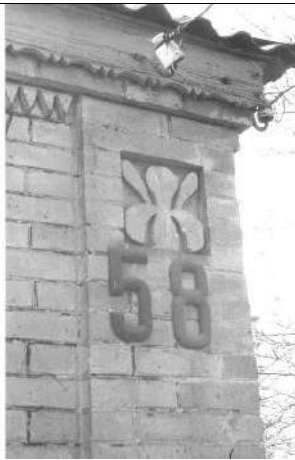
Мал. 54. Будинок по вул. Хрещатик, м. Черкаси, сер. XX ст. Фото автора.
