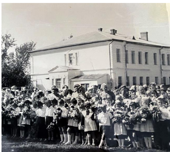
1960-ті, будівля школи 1899 р. побудови.
